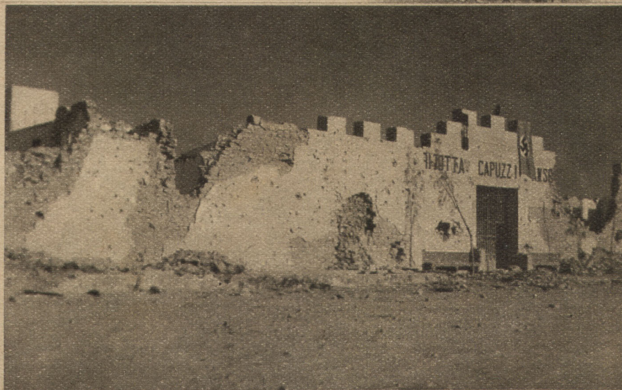
El fuerte Capuzzo, al sudoeste de Sollum en la frontera entre Libia y Egipto, que ha conseguido ya una importancia histórica en los combates del Africa Septentrional. Alrededor de esta importante fortaleza fronteriza se ha luchado repetidas veces con encono y denuedo. Los muros presentan huellas de las violentas luchas.
